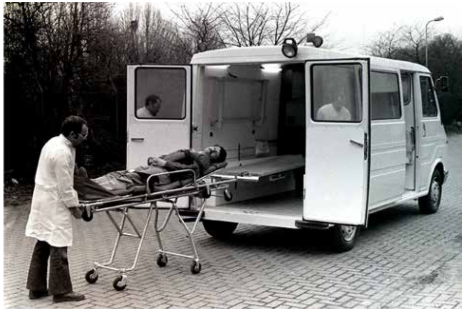
Afbeelding 8. Het prototype van de SAM als ontworpen door Hans Pijpers uitgevoerd op een Citroën C35 en uitgerust met een Unihef zwevende brancarddrager. Let op: de patiënt ligt (helaas) nog steeds op de achteras (fotograaf: ©Piet Hoving, Nijmegen).
